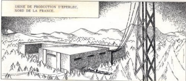
DANS CETTE IMMENSE INFRASTRUCTURE DE BETON ET DE METAL, LA CONSTRUCTION DES V2 SE REALISE A LA CHAÎNE.
